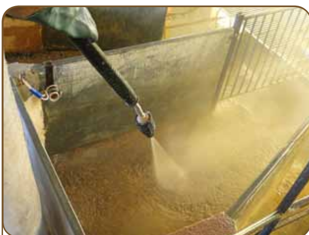
Figura 23: Retirada da sujeira com água sobre pressão.
